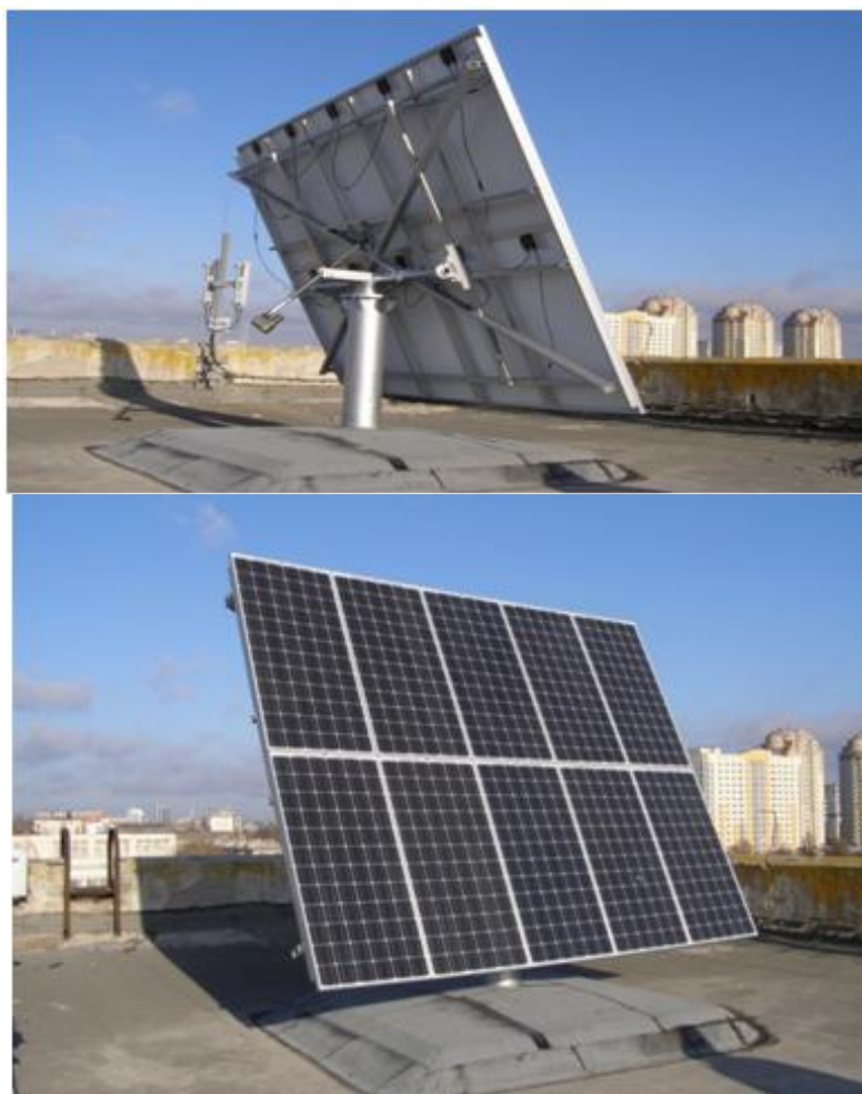
Поворотна платформа сонячної енергетичної установки
